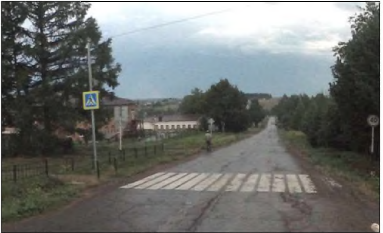
Рисунок 1.7.5 – Пример эксплуатационного состояния разметки 1.14.1 на Ашап, пер Советский
