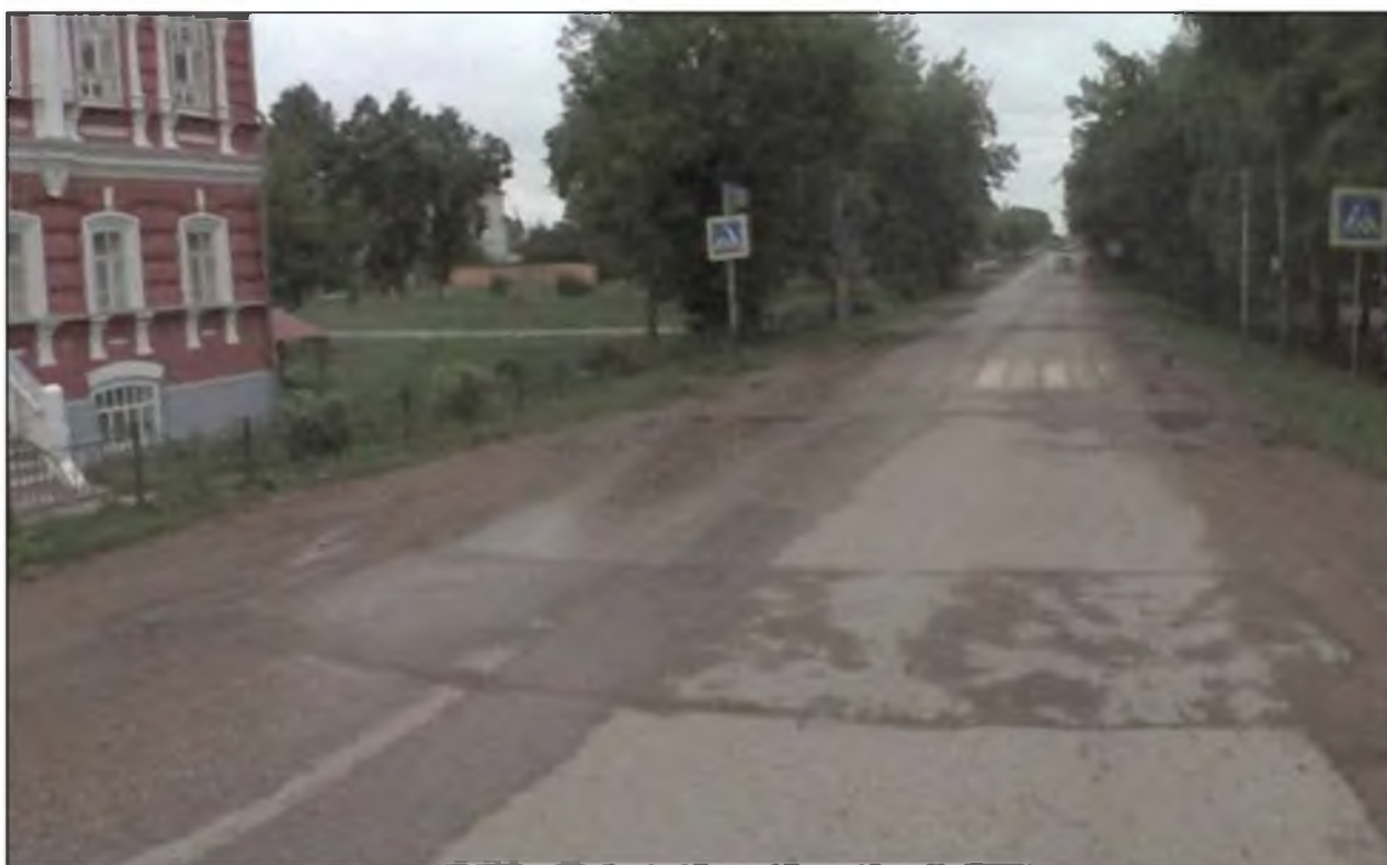
Рисунок 1.7.6 – Пример эксплуатационного состояния ИН неровности монолитной конструкции, расположенных по ул. Советская, с. Орда
