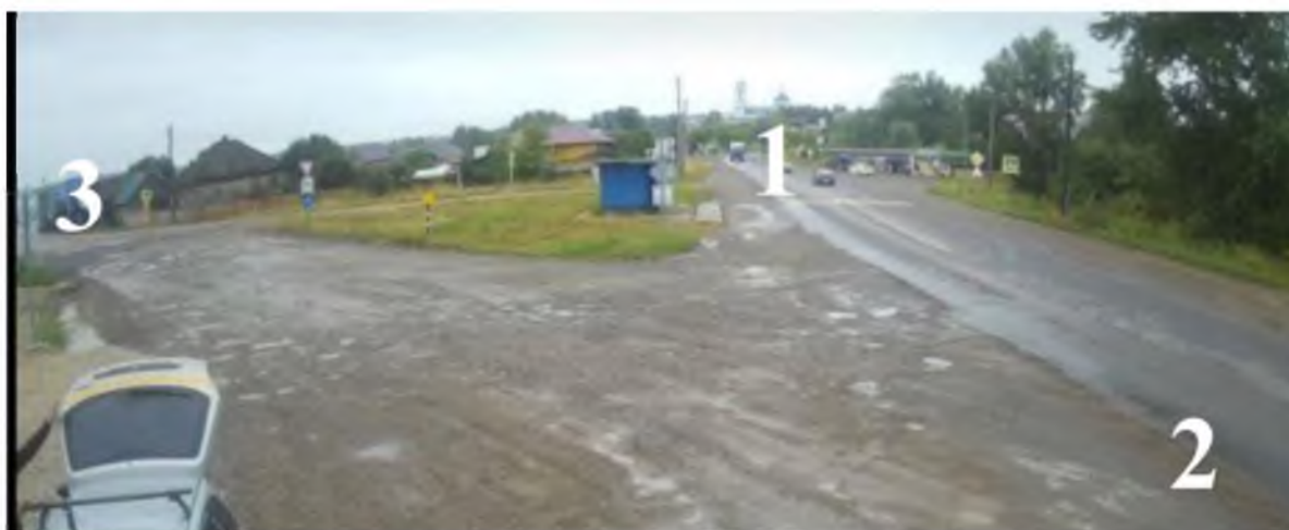
Рисунок Г.9.2 – Фото перекрестка ул. Тракторная – ул. Заречная, с. Орда
